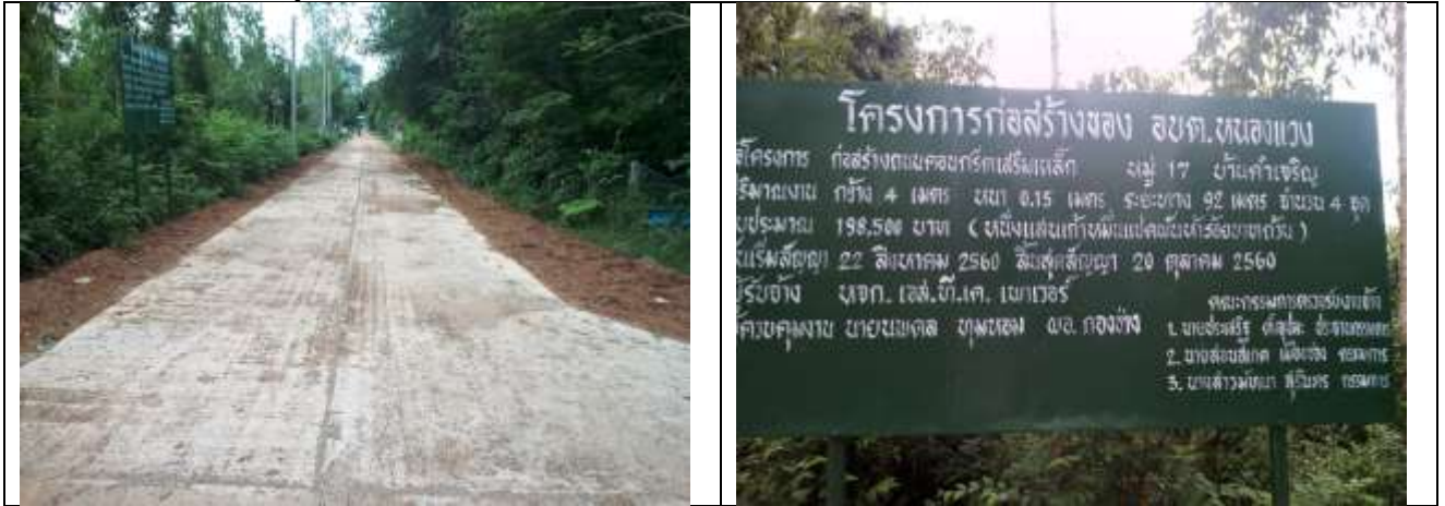
๑๗.ก่อสร้างถนน คสล. หมู่ ๒ บ้านหนองแขวง
