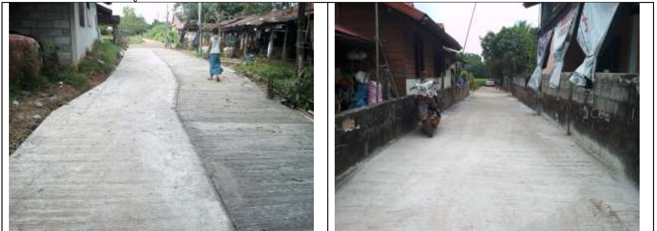
๑๘.ก่อสร้างถนน คสล. หมู่ ๙ บ้านโนนสมบูรณ์
