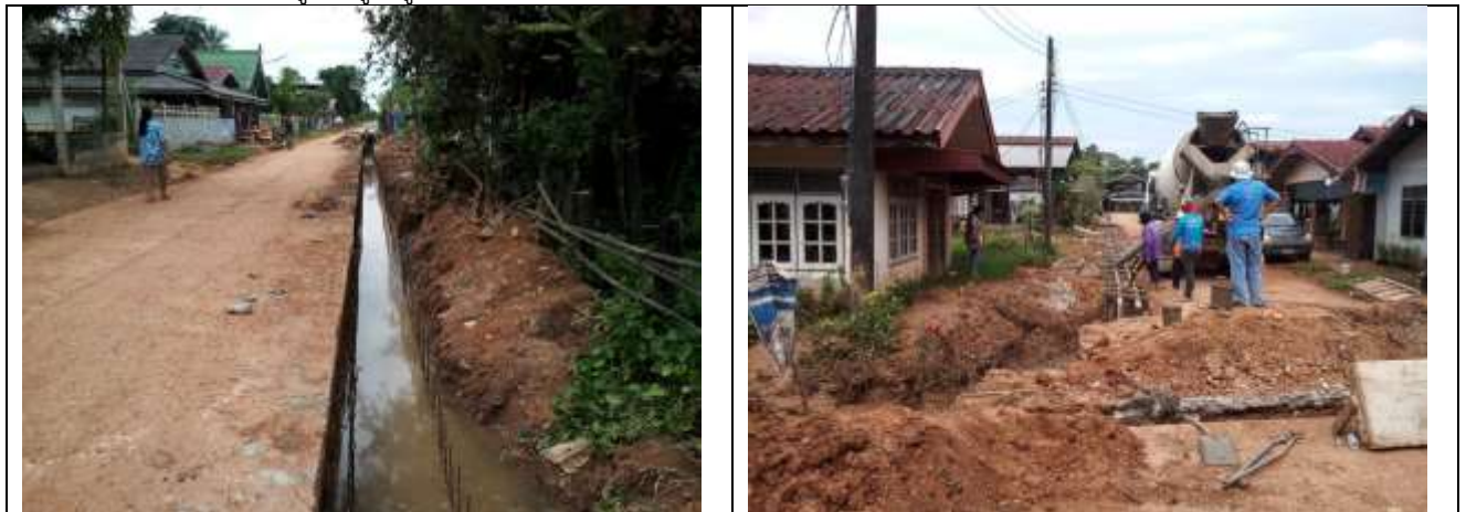
๒๒.ก่อสร้างรางระบายน้ำรูปตัวยู หมู่ ๘ บ้านดอนกลาง
