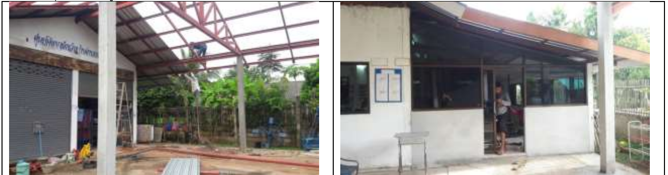
๗.ก่อสร้างที่จอดรถจักรยานยนต์
