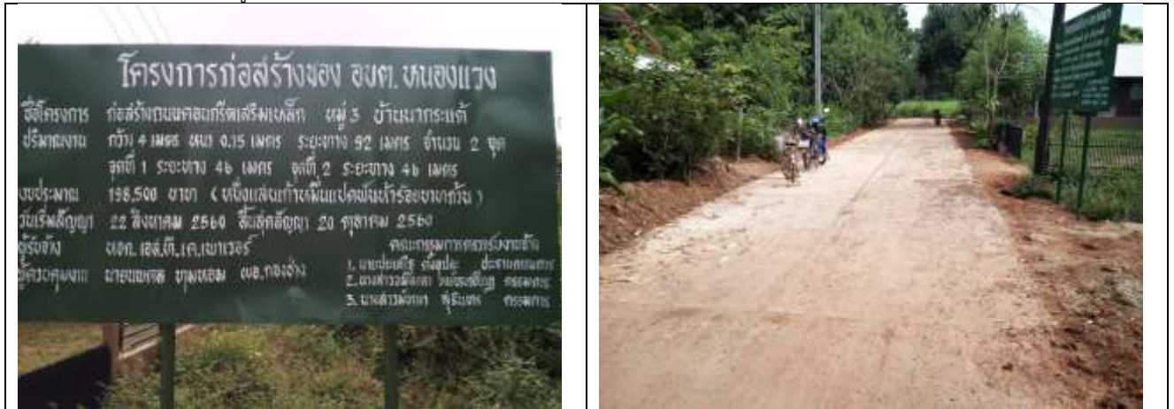
๒๑.ก่อสร้างรางระบายน้ำรูปตัวยู หมู่ ๖ บ้านดอนกลาง
