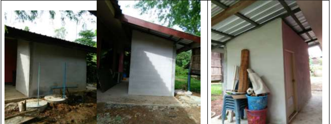
๖.ปรับปรุงซ่อมแซมศูนย์พัฒนาเด็กเล็กบ้านค่านกกกเหนือ
