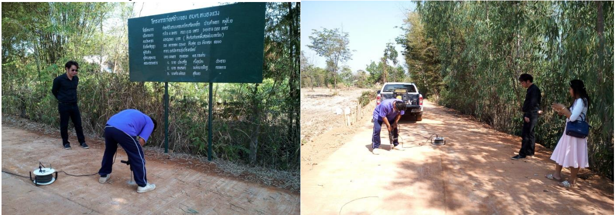
๕. ก่อสร้างถนน คสล. หมู่ ๒ บ้านหนองแวง
