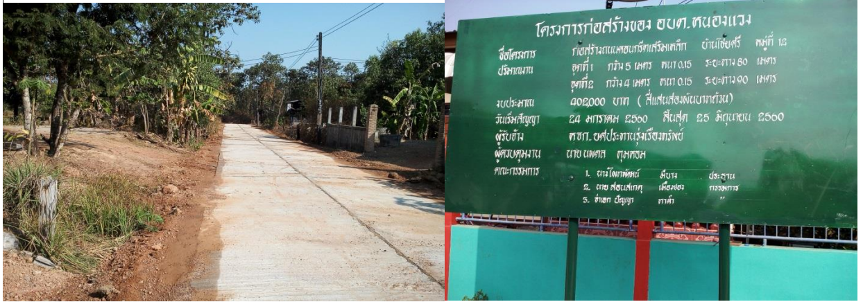
๔. ก่อสร้างถนน คสล. หมู่ ๑๐ บ้านคำพอก
